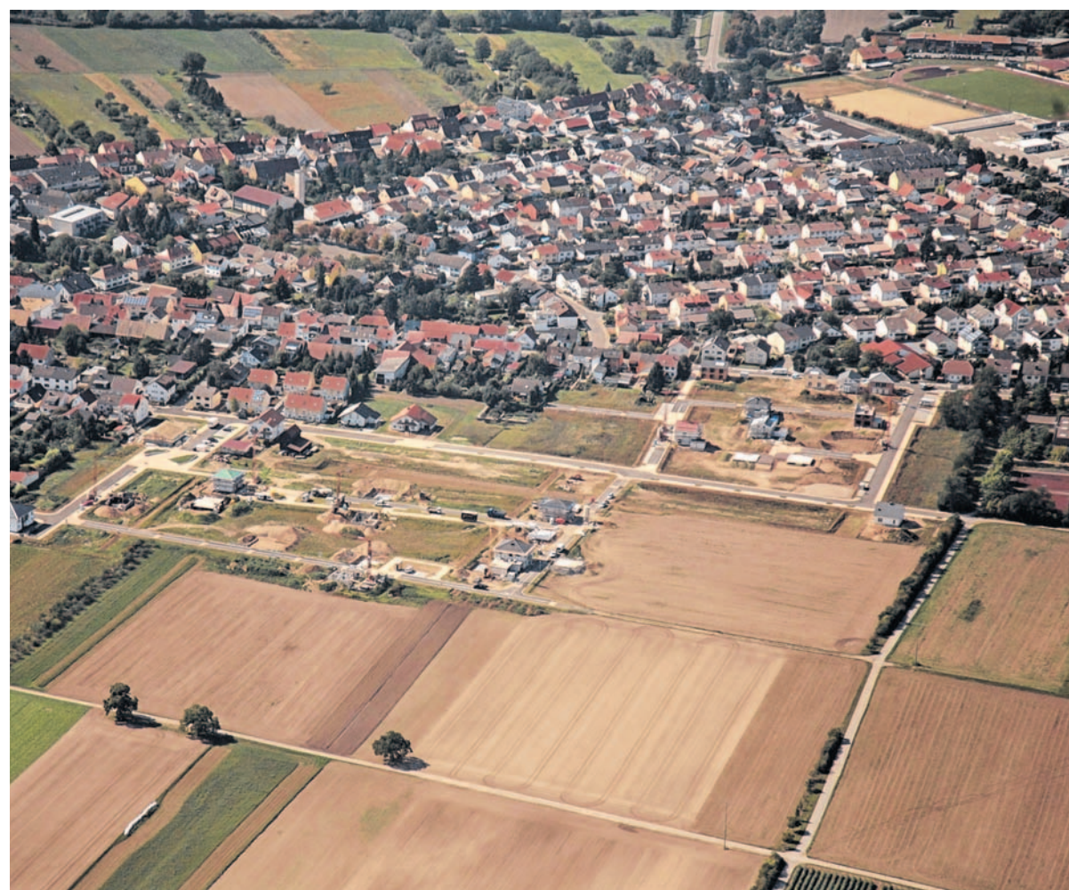
Im Neubaugebiet „Hockenheimer Flur“ wird fleißig gebaut. Südlich davon ist der zweite Bauabschnitt zu sehen. BILD: KYRBERG
